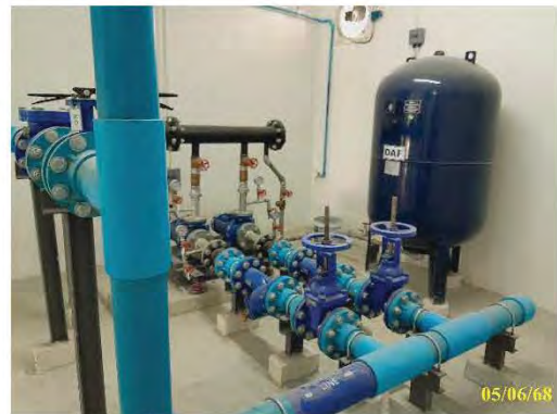
ถังสำรองน้ำชั้นดาดฟ้า พร้อมเครื่องปั้มน้ำชั้นดาดฟ้า
