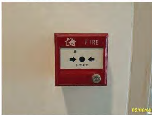
กดแจ้งเหตุแบบใช้มือ (Manual Station)
